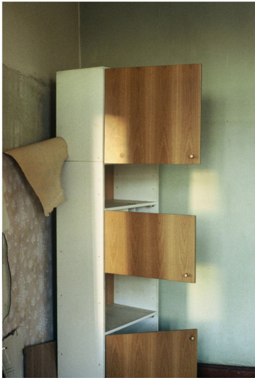
Schrank, Reichsbahnausbesserungswerk, Berlin, 1997
